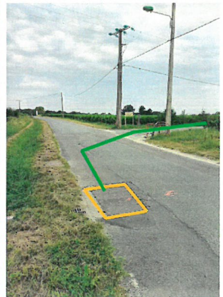
Cheminement de FO FREE de la chambre 79 en passage vers chambre Orange 81 (0) à percuter
